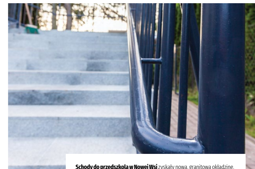
Schody do przedszkola w Nowej Wsi zyskały nową, granitową okładzinę, a także dodatkową poręcz dostosowaną do wzrostu dzieci.
