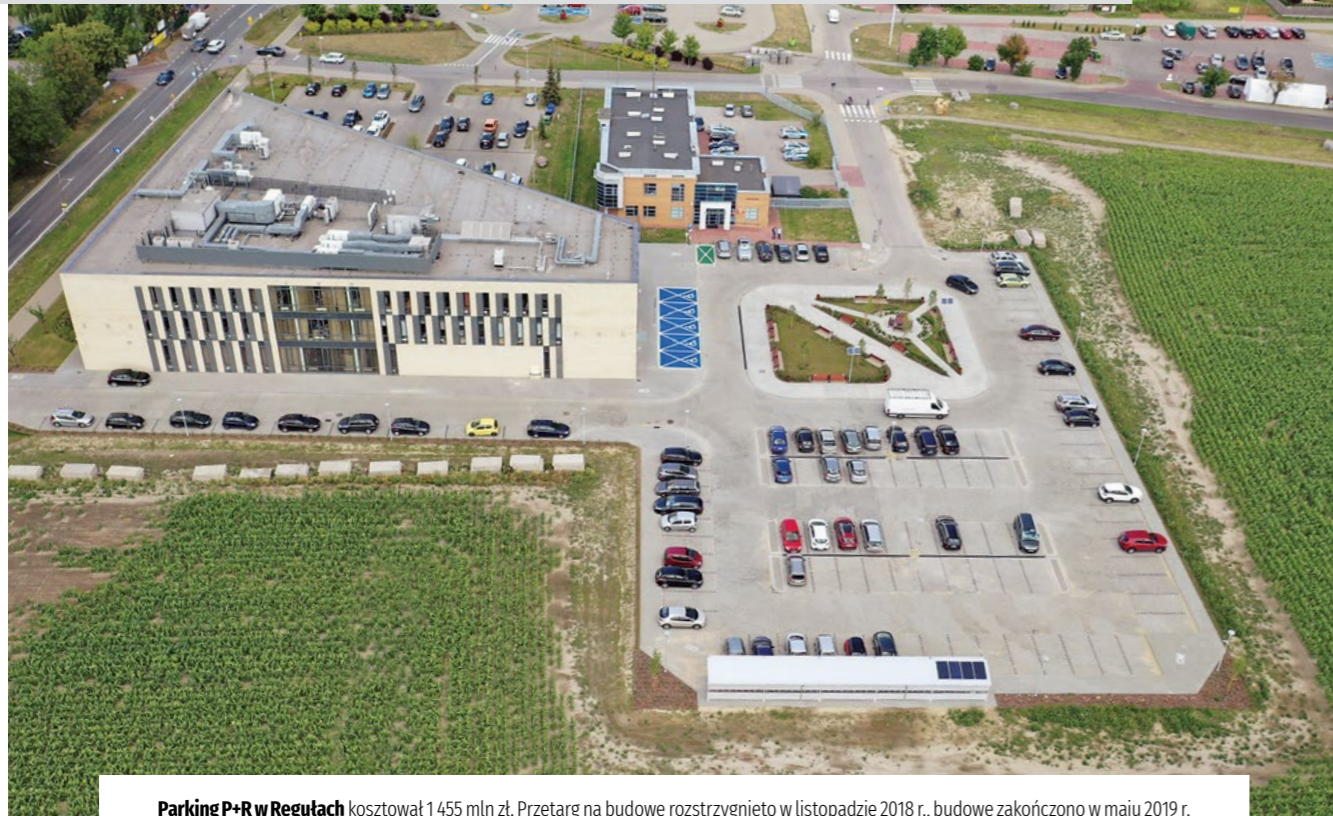
Parking P+R w Reguła kosztował 1 455 mln zł. Przetarg na budowę rozstrzygnięto w listopadzie 2018 r., budowę zakończono w maju 2019 r.
