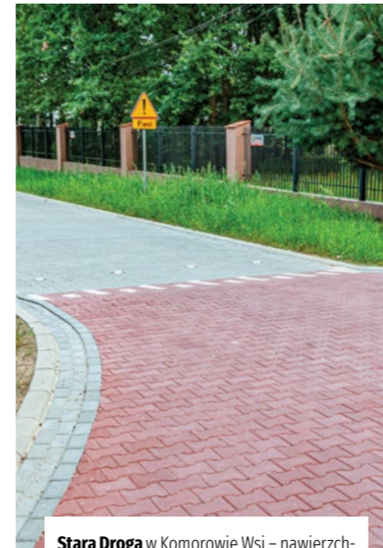
Stara Droga w Komorowie Wsi – nawierzchnia wyremontowana kosztem 846 tys. złotych, inwestycja zakończona w czerwcu 2019.
