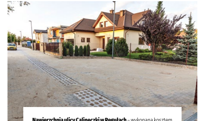
Nawierzchnia ulicy Calineczki w Reguła – wykonana kosztem 326 tys. złotych. Przetarg rozstrzygnięto w czerwcu 2019, zakończono w lipcu 2019.
