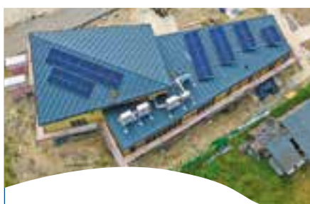
Budowa budynku świetlicy wiejskiej w Pęcicach
