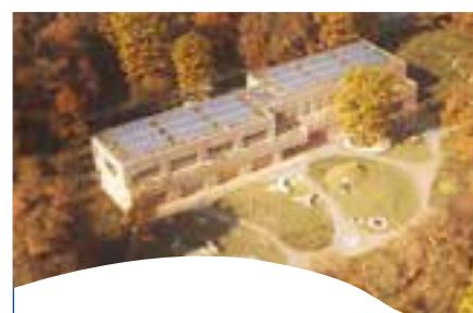
Budowa przedszkola w Michałowicach
